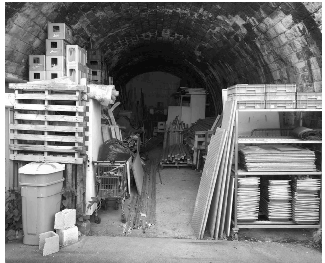
Figure 6. Image de la voûte existante. Source : studio de conception « Cycle de la matière ».
