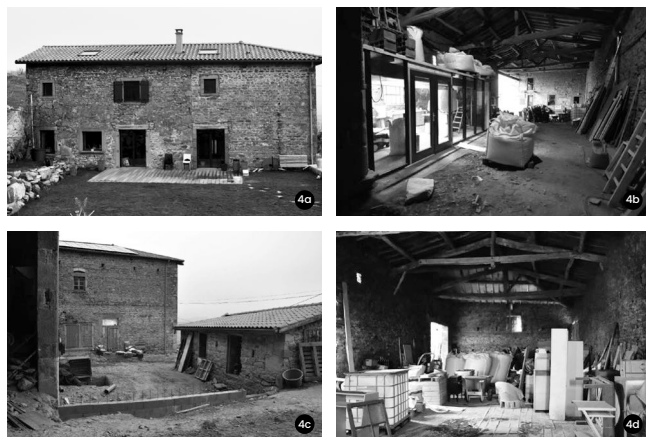
Figure 4. Ferme de F.B. et E.B., Monts du Lyonnais (Rhône), en janvier 2021: transformations réalisées, en cours et projetées. 4a: la maison rénovée en 2015, façade extérieure; 4b: le moulin à céréales auto-construit en 2019 sous le chapi; 4c: les travaux de terrassement en cours (auto-réalisation); 4d: la grange, un projet dont on n'a pas de le temps de s'occuper. Source: photos équipe de recherche « Fermes U+ ».
